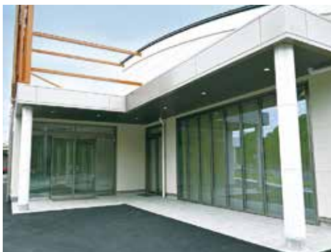
支店南入口と会議室
