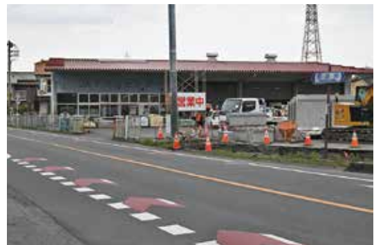
フェンス・舗装工事により、しばらく出入口が変更になります。
