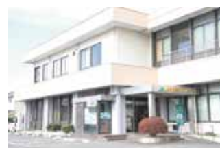
仮店舗となる京ヶ島支店
