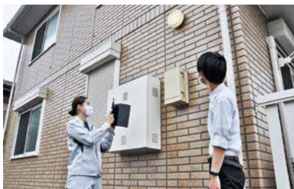
外壁を点検確認
