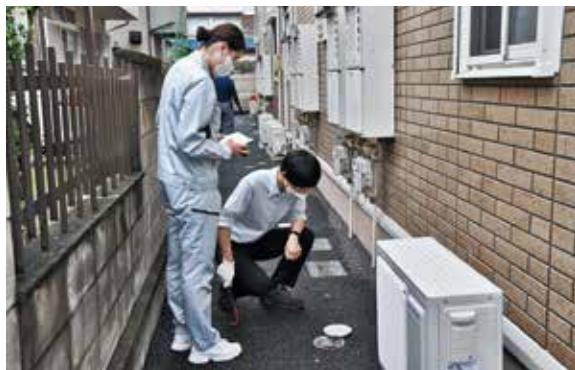
排水溝を点検する担当者
