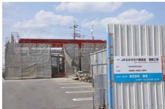
Bエリア写真 順調に進む増築工事
