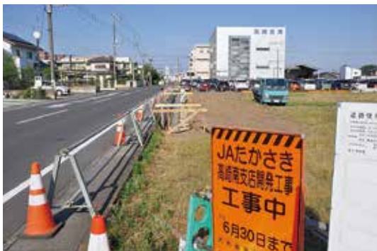
Aエリア写真 擁壁の工事中です
