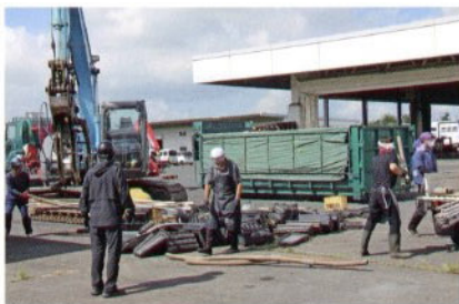
廃資材回収作業
