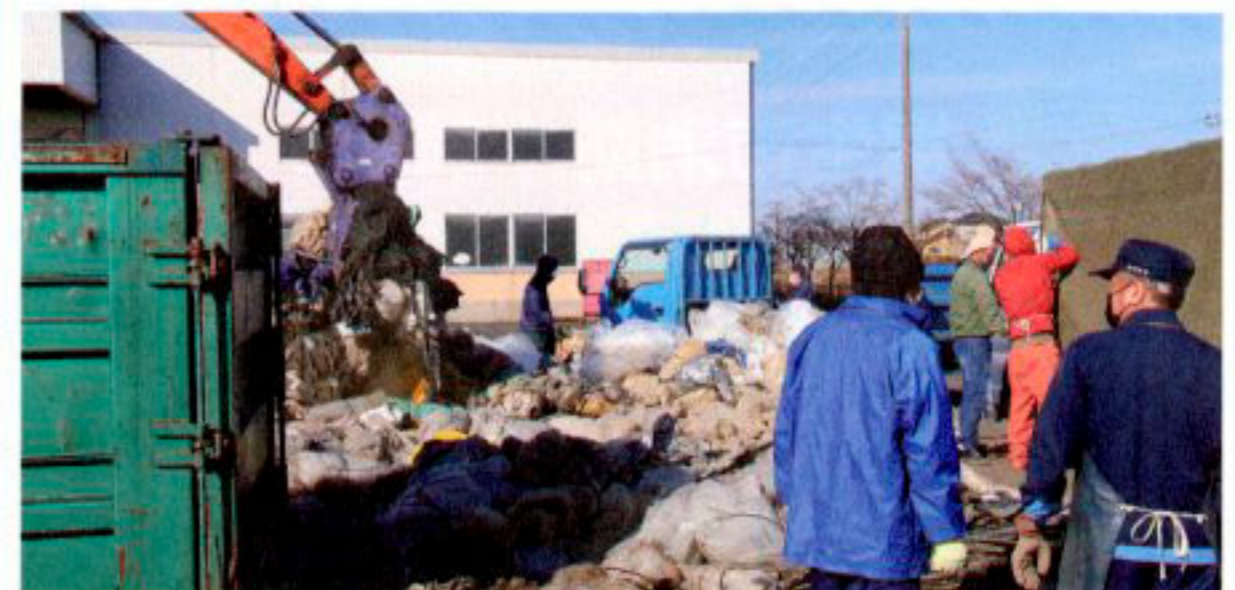
◀ 廃ポリ回収作業
