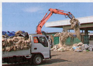
廃ポリ回収作業
