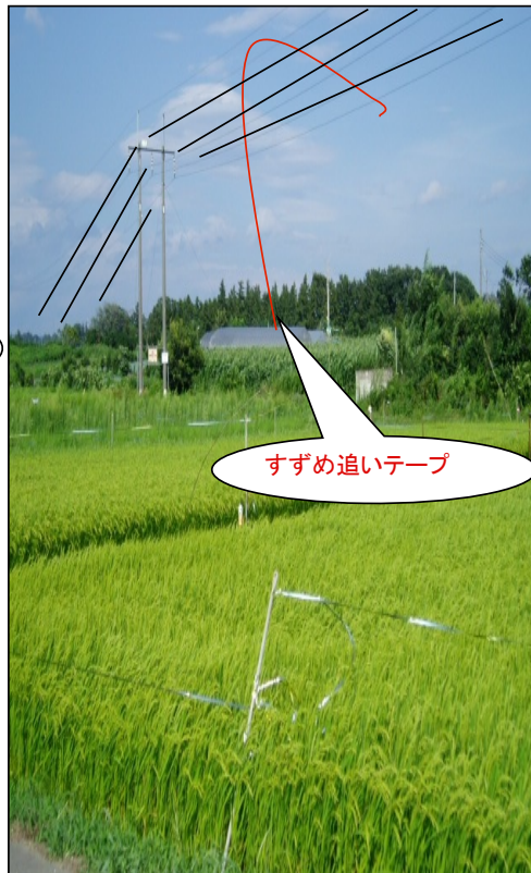
送電線コン柱(すずめ追いテープ)
